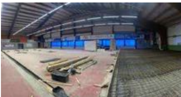
Im Bau: das neue Tischtenniszentrum am Silberweg
