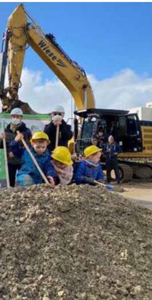
Bagger ohne Bodo: Spatenstich zum Bau der neuen Kita
